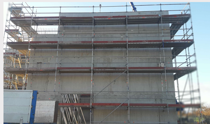
Trafo stacja 1200m 2 Trelleborg ściany LEIER (12m wysoka)
