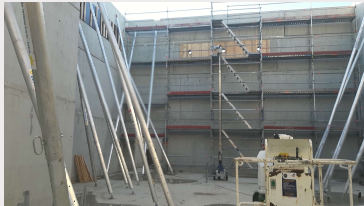
Trafo stacja 1200m 2 Trelleborg ściany LEIER (12m wysoka)
